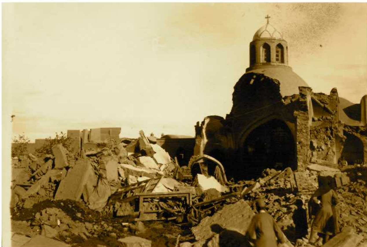
ساختمان کلیسای جمیع مقدسین در اثر سیل ناگهانی ویران شد All Saints church in Yazd was destroyed by a flood
